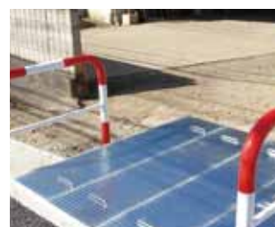
排水溝の水音対策。蓋に設置
