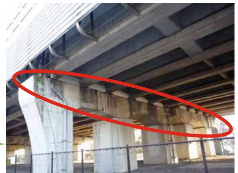
対策箇所（関越自動車道）
